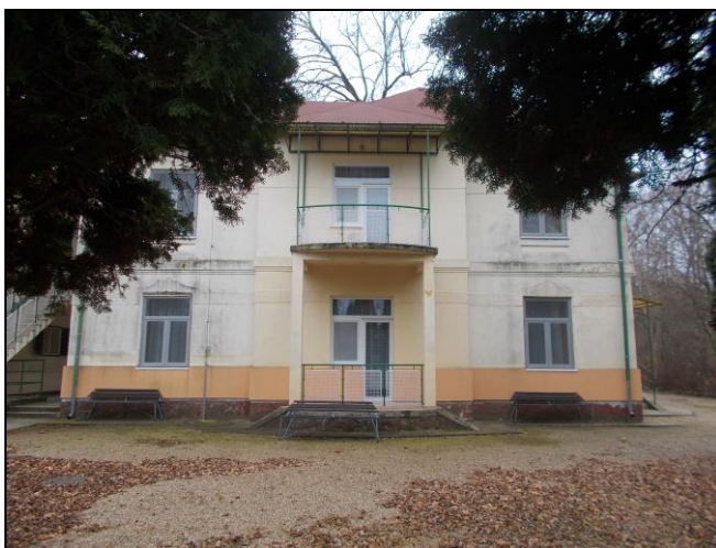
Az épület a 158/1 hrsz-ú út felől
